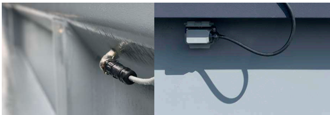
Onder: Aansluiting op schip - Door Elektriciën
